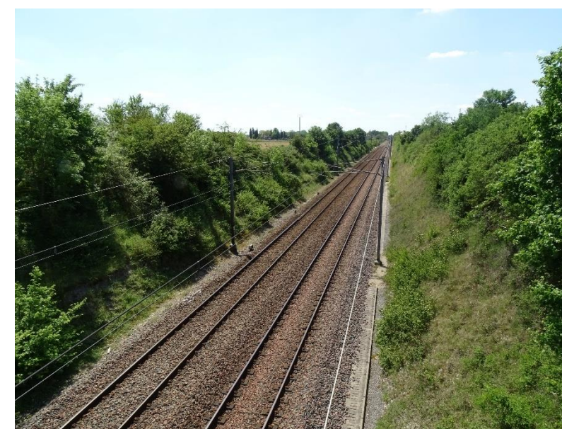
Photo n°25 : Voie Ferrée Niort-La-Rochelle
