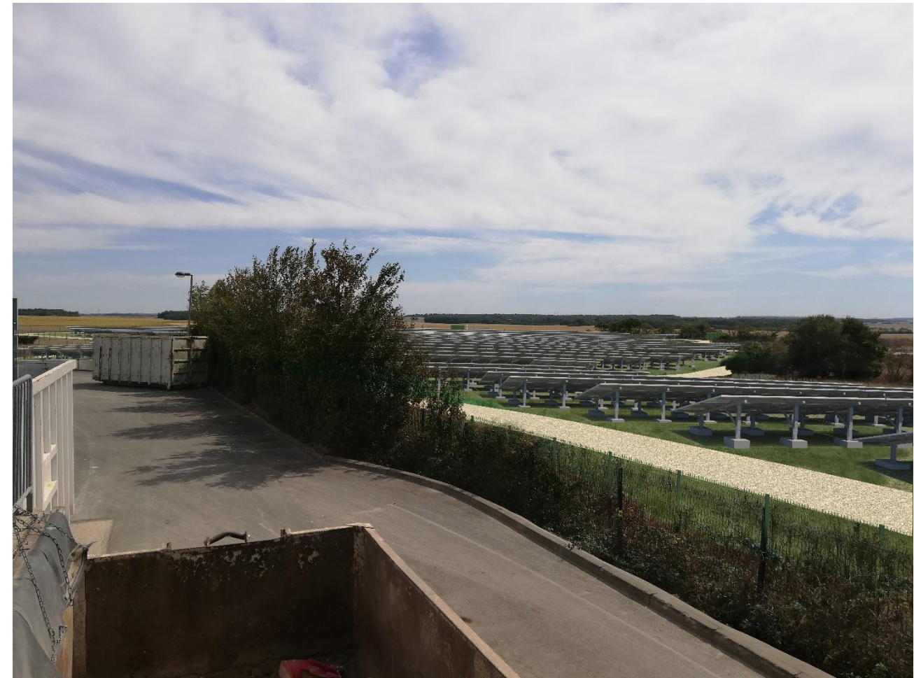
Etat final du site
