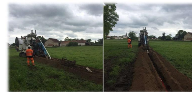
Exemple de chantier d'enfouissement d'un réseau électrique en terres agricoles (source : Cegelec infra)
