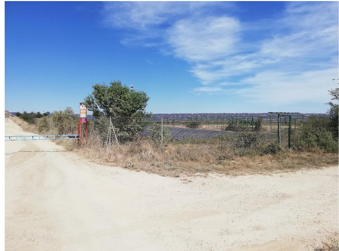
Etat final du site
